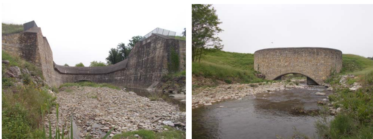
Figura 9: foto dell'opera di sbarramento della cassa d'espansione sul Torrente Ciuffenna
