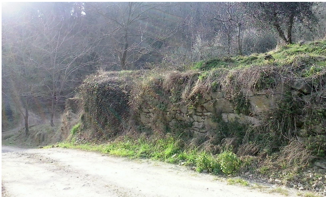
Foto 12: fabbricato demolito della sottoparticella 3/3 (I Sodacci)
