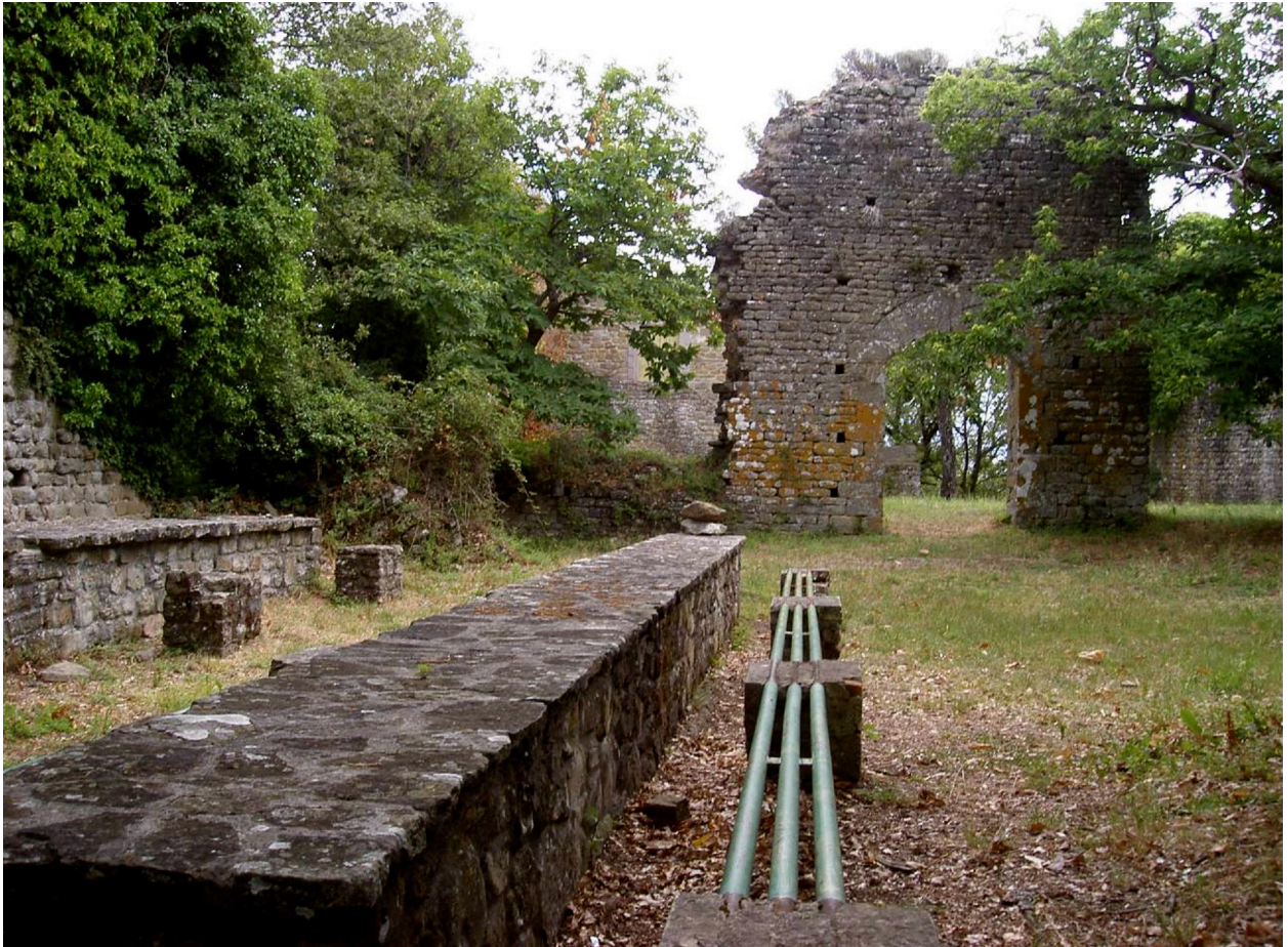
Foto 8: Forte di Monte Domenichi: cortile con area di sosta e porta centrale.
