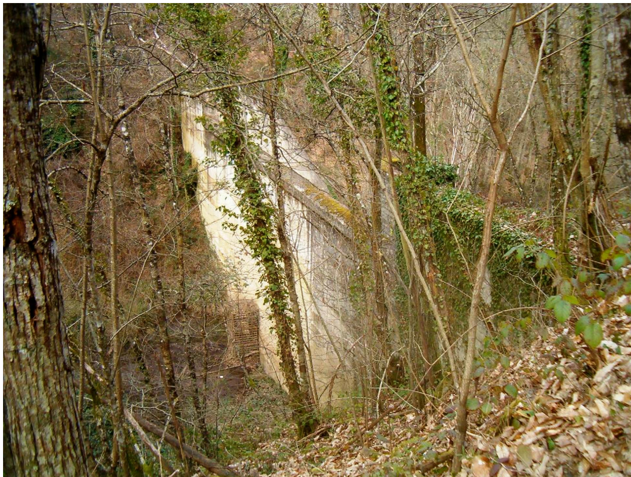
Foto 1: uno degli imponenti sbarramenti presenti nel complesso forestale (Borro del Mulinaccio o Fosso Pago), finalizzati alla laminazione delle piene ed alla deviazione delle acque al di fuori del bacino minerario; si nota in basso lo scarico di fondo chiuso da una griglia.
