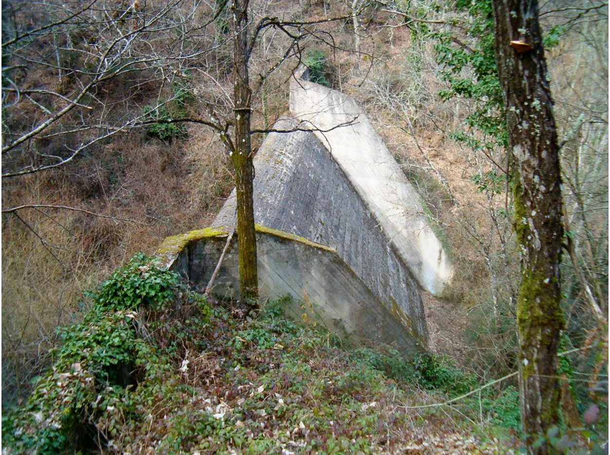
Foto 2: la stessa opera vista da valle.
